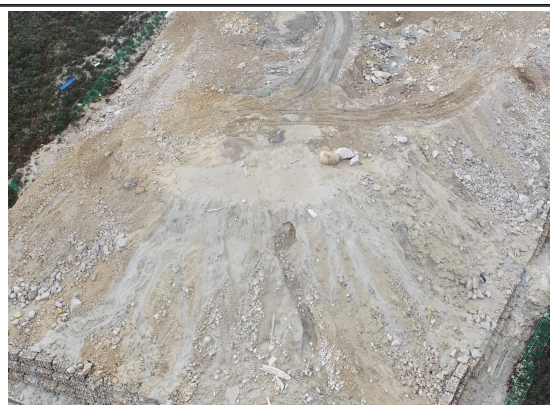
施工期弃渣场现状
