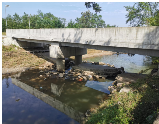
图 2-13 N9+936 机耕桥 (改造过洪断面)
