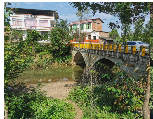
图 2-11 N8+989 机耕桥（原址重建）
