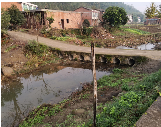
图 2--9 N0+946 机耕桥（拆除重建）
