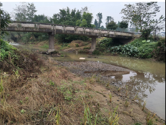
图 2-10 N8+422 机耕桥（拆除重建）
