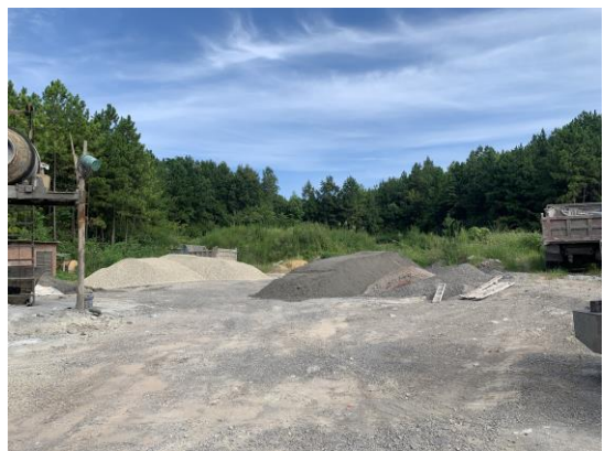
照片 4：项目冷拌站占地现状
