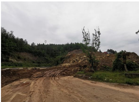
照片 1：项目热拌站占地现状
