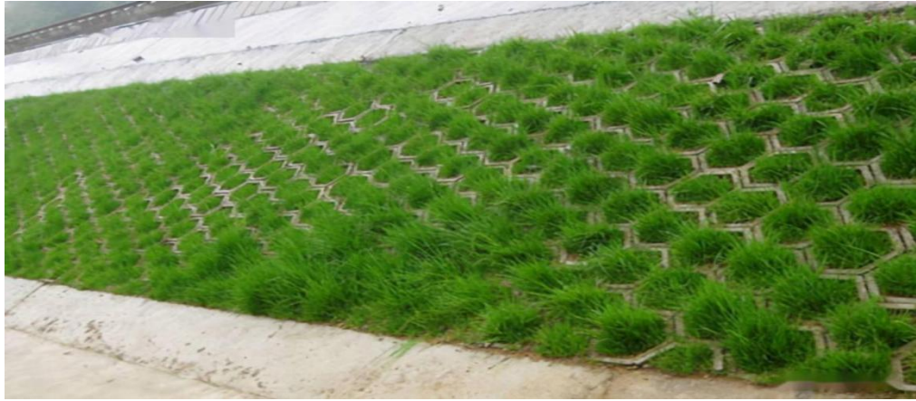
图 2-9 框格内嵌预制空心六棱块植草护坡
