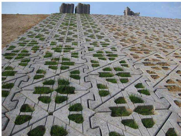
图 2-11 铰链式预制砼护坡图
