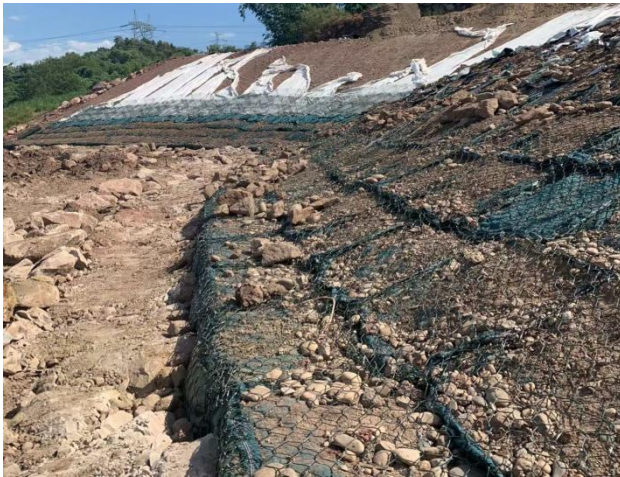
图 2-12 生态折叠箱护坡图
