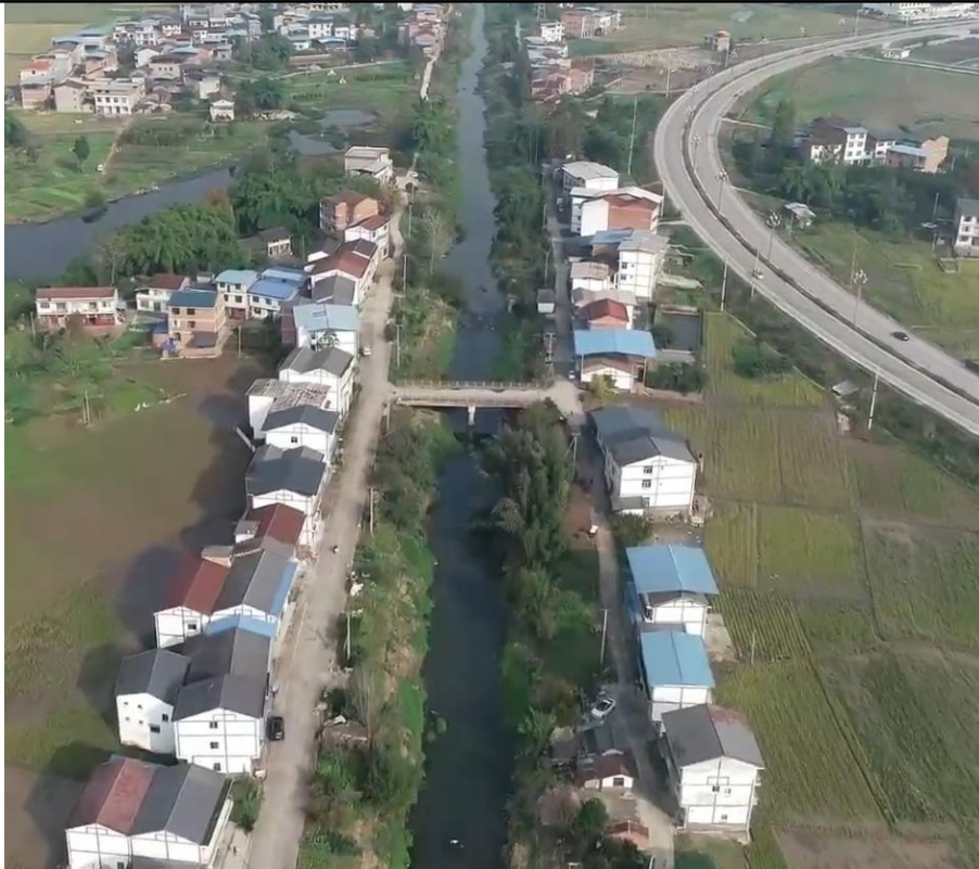
图 3-9 现状汇合口上游河道及两岸情况
