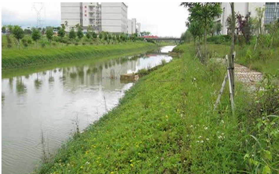
图 2-10 无砂砼植草护坡图
