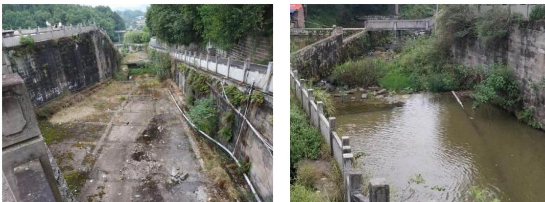
图 3-3 溢洪道底板及消力池底板破损
