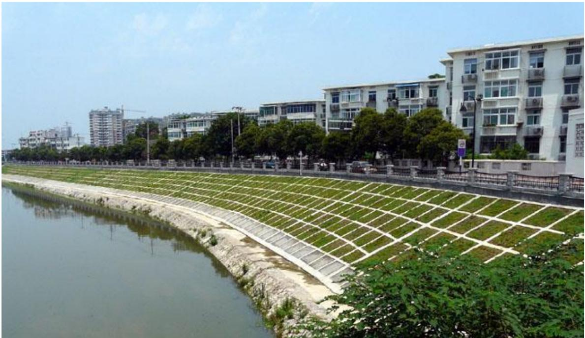
附图 2-1 生态护岸工程示意图
