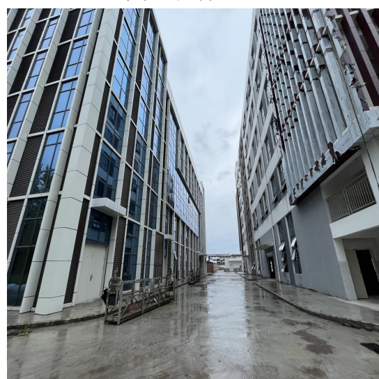
项目西侧厂房
