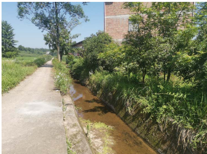
项目现状沟渠
