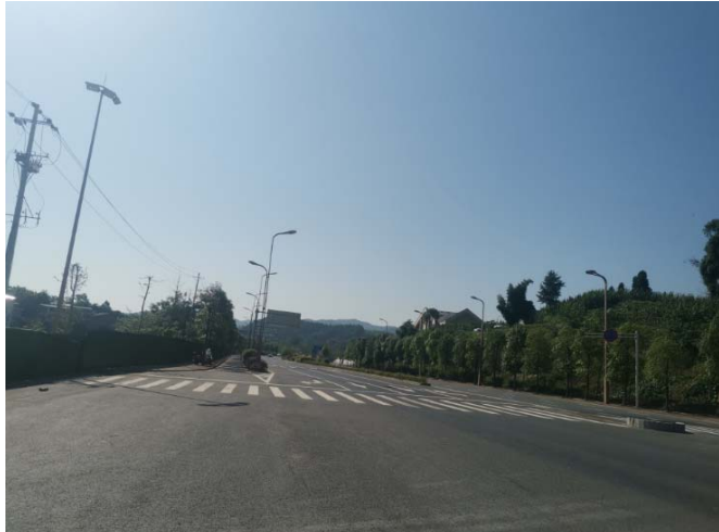
项目道路起点
