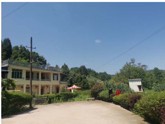
项目道路终点
