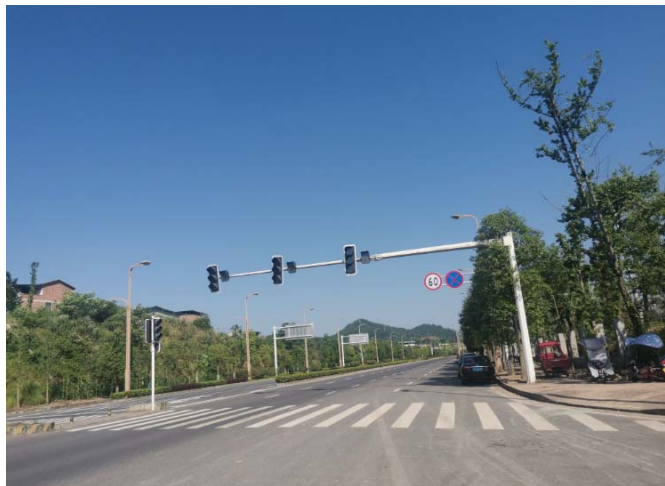
项目道路起点
