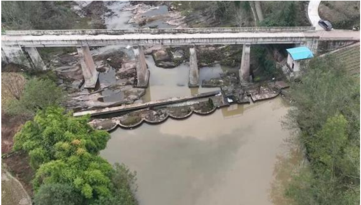
图 3-11 下段控制断面——清泉电站拦河坝
