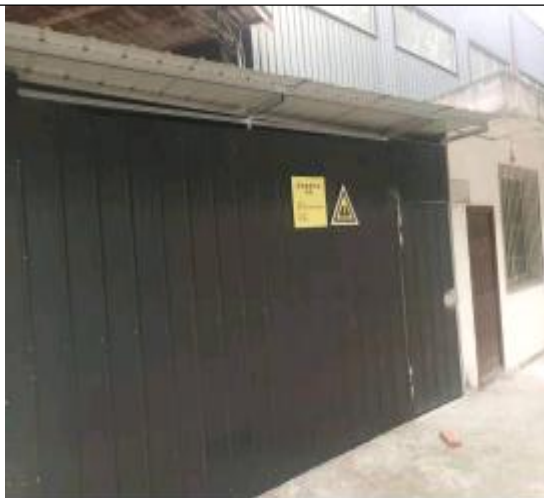
危废暂存间单独房间-样图
