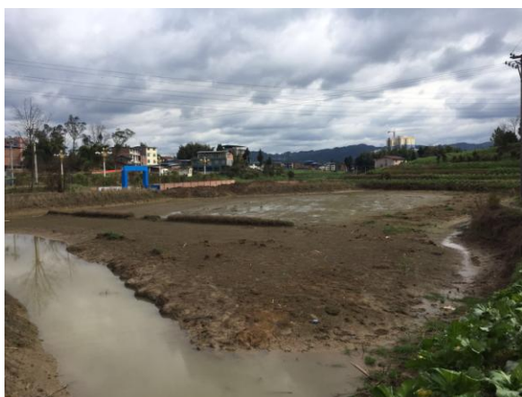
项目西侧空地
