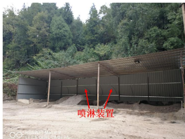
整改后：配料场三面封闭围挡+洒水喷雾设施
