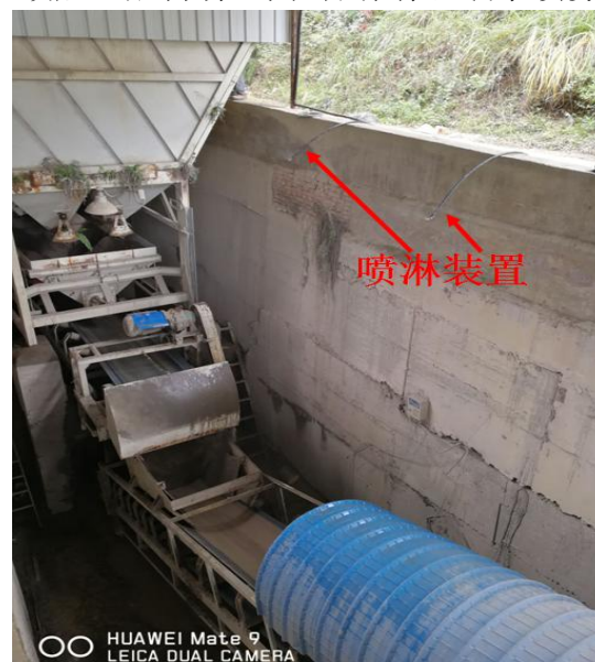
整改后：配料斗卸料处设置洒水喷雾设施
