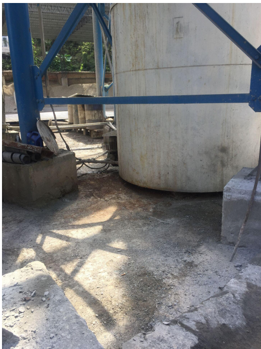
整改前：外加剂桶处无围堰
