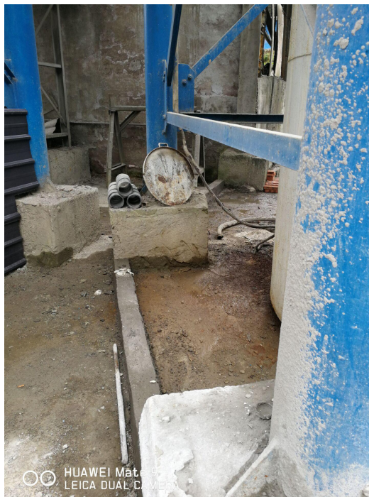
整改后：外加剂桶处设置围堰
