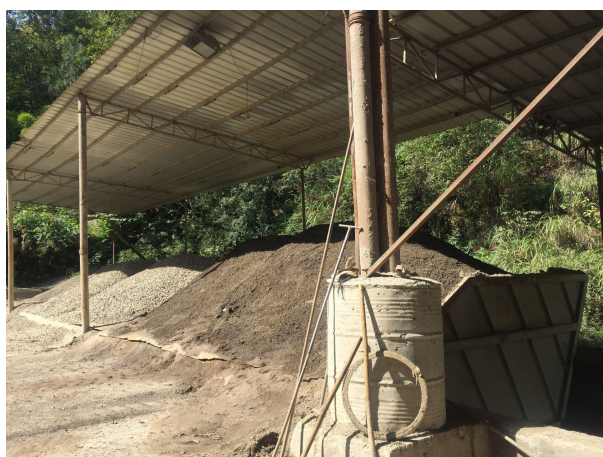
整改前：配料场设置雨棚
