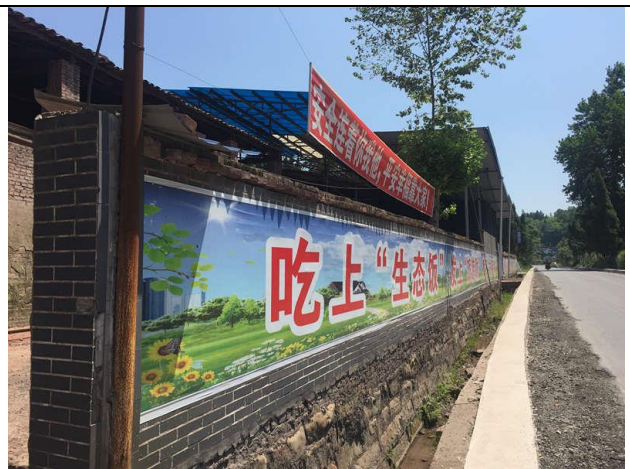
厂界围墙+雨排沟
