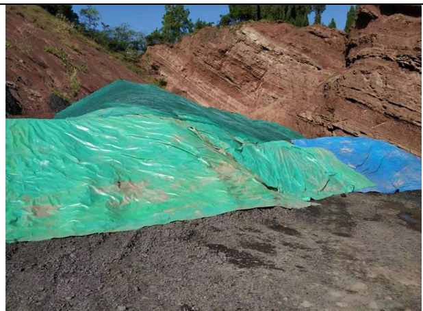
煤矸石堆场滞尘防护网遮盖
