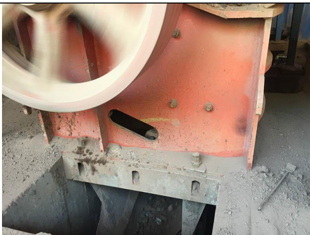
破碎机半地埋式安装+固定减震
