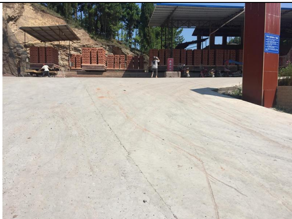
进厂道路硬化
