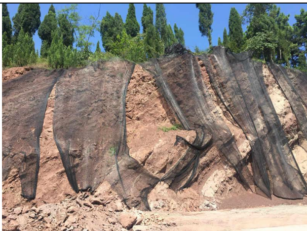
页岩矿山滞尘防护网遮盖
