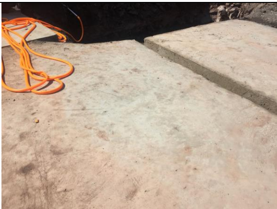
车辆冲洗平台
