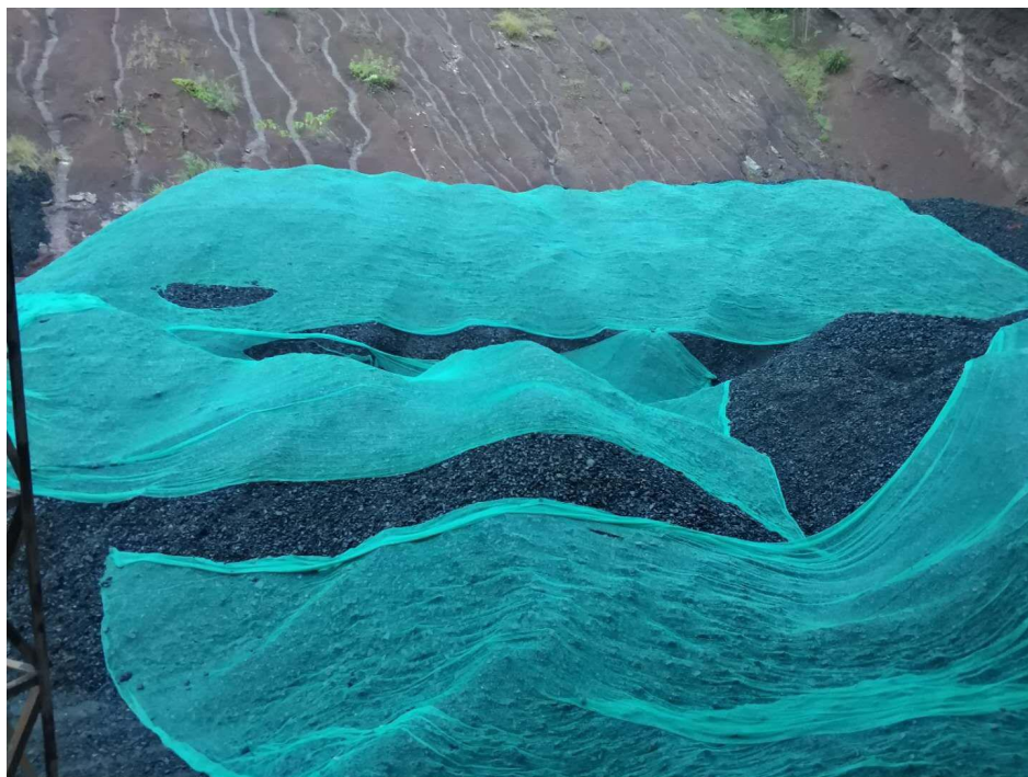
煤矸石堆场滞尘防护网遮盖
