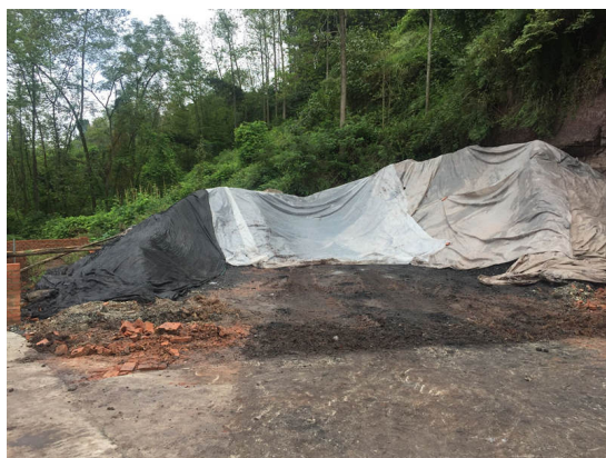
整改前：煤矸石堆场围挡较低
