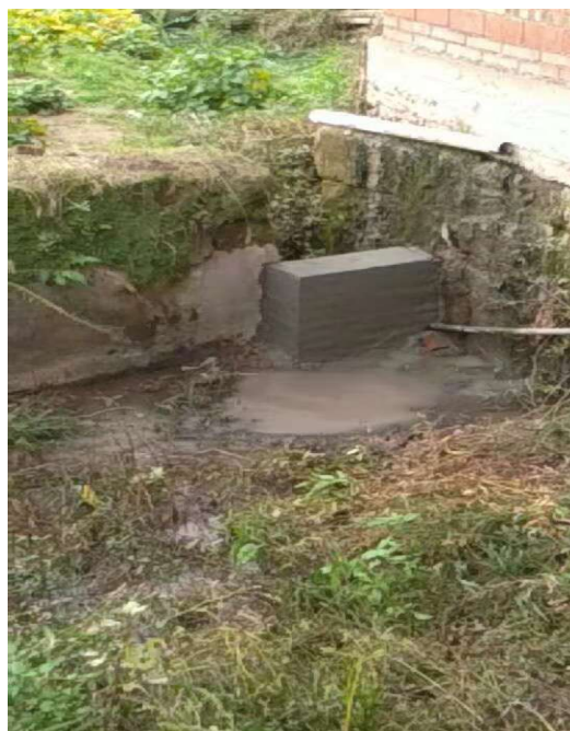
整改后：池子排口溢流挡墙
