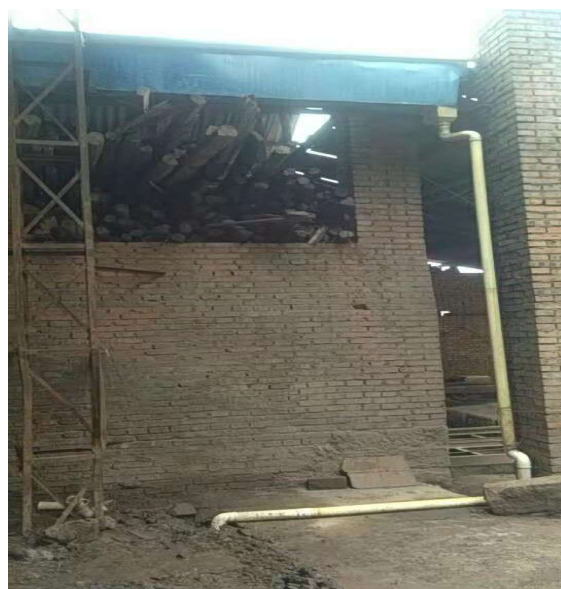
整改后:雨棚排水管接至地下管道
