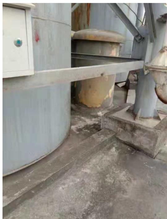
整改后：外加剂桶处设置围堰
