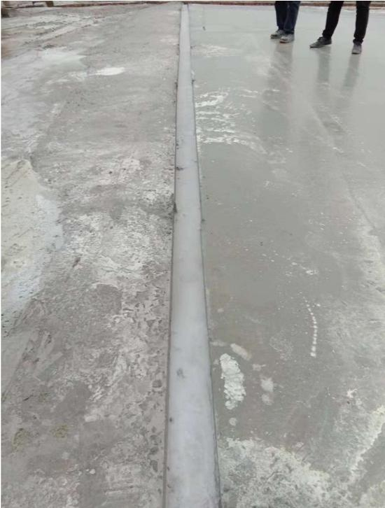
整改后：车辆冲洗处设置导流沟
