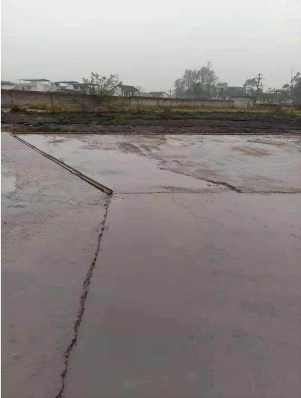
整改前：车辆冲洗处无导流沟和截流沟
