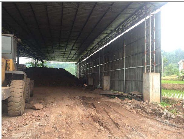
原料堆场围挡，彩钢瓦顶棚
