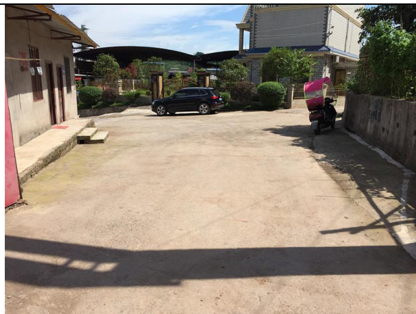
进场道路硬化
