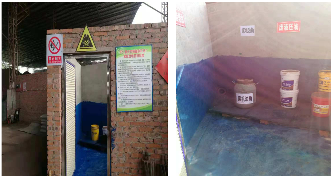
危险废物暂存间
