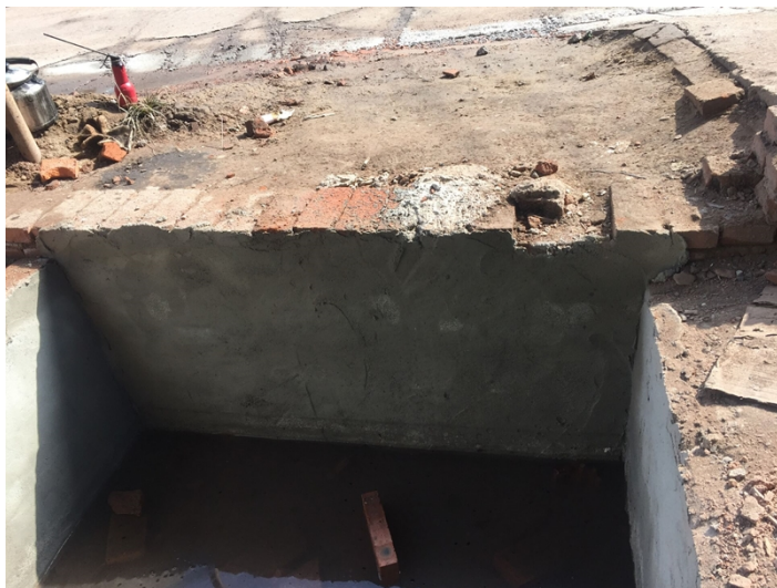
窑车下方池子硬化
