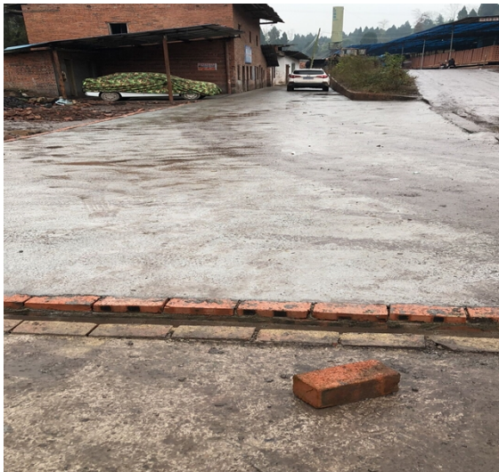
进场左边地面硬化
