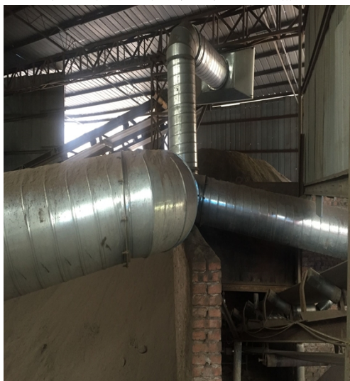
整改前：集尘罩位置离输送机末端较远
