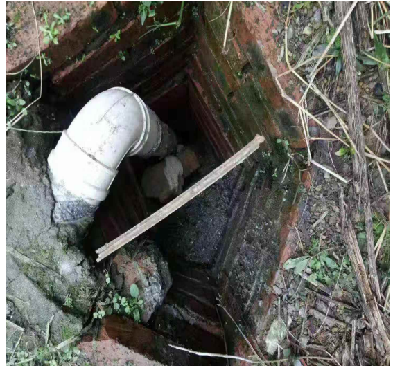
整改后：污水处理站废水排口涵管封堵
