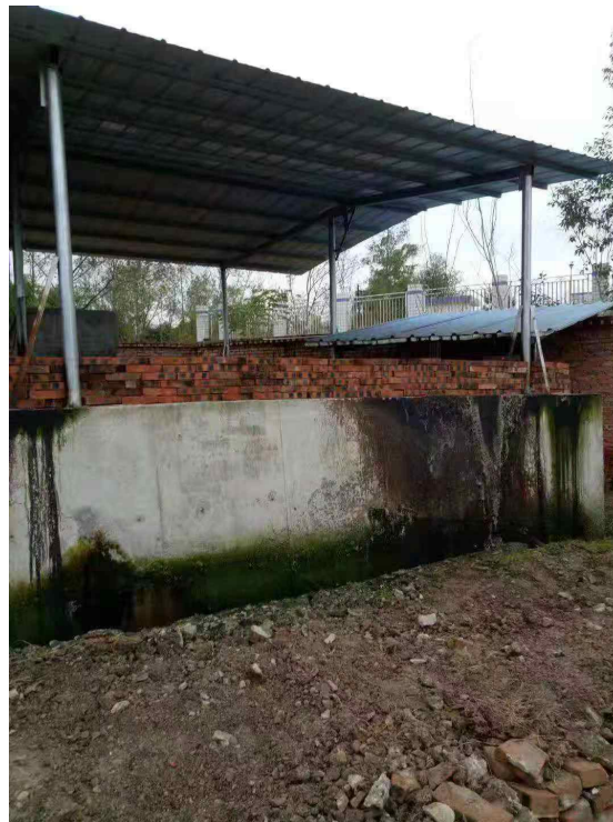
整改后: 污水处理站产泡沫处加修 1 尺砖
