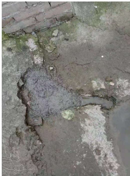
整改后：消毒池洞口封堵
