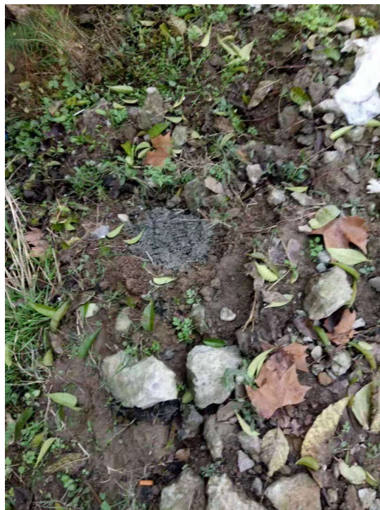
整改后：进出口大门流向外面的洞口封堵
