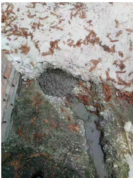
整改后：消毒池洞口封堵
