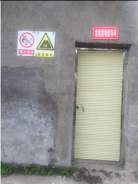
危险废物暂存间
